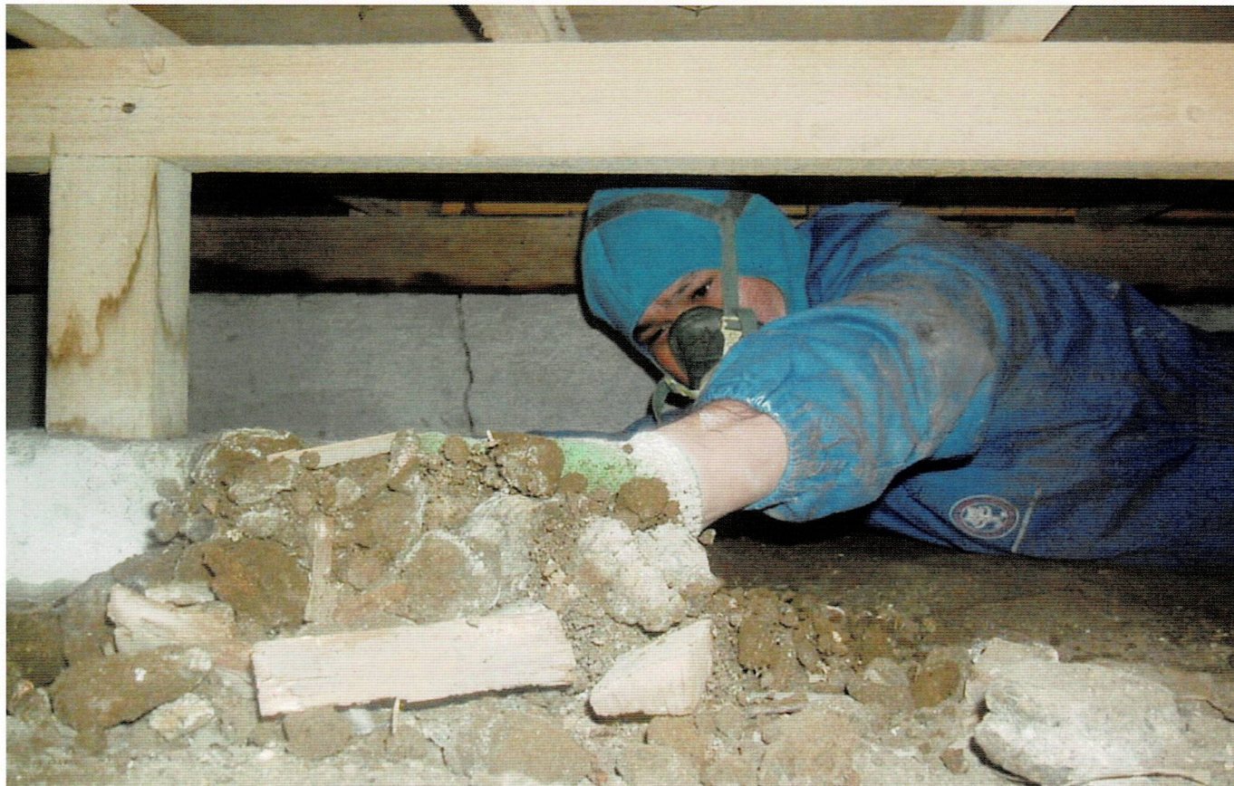
基礎内部整地前状況
