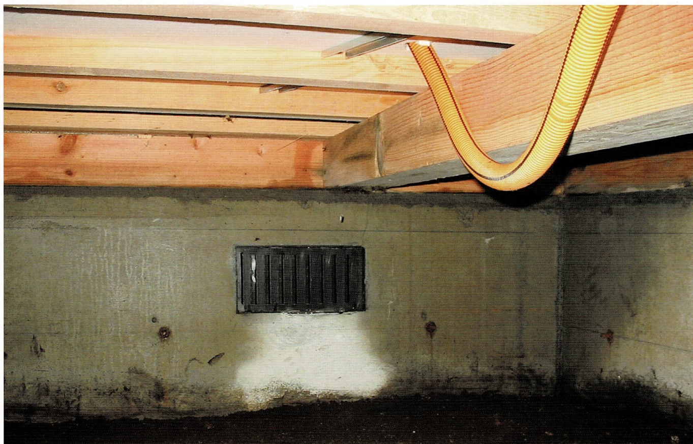
基礎内部整地前状況
