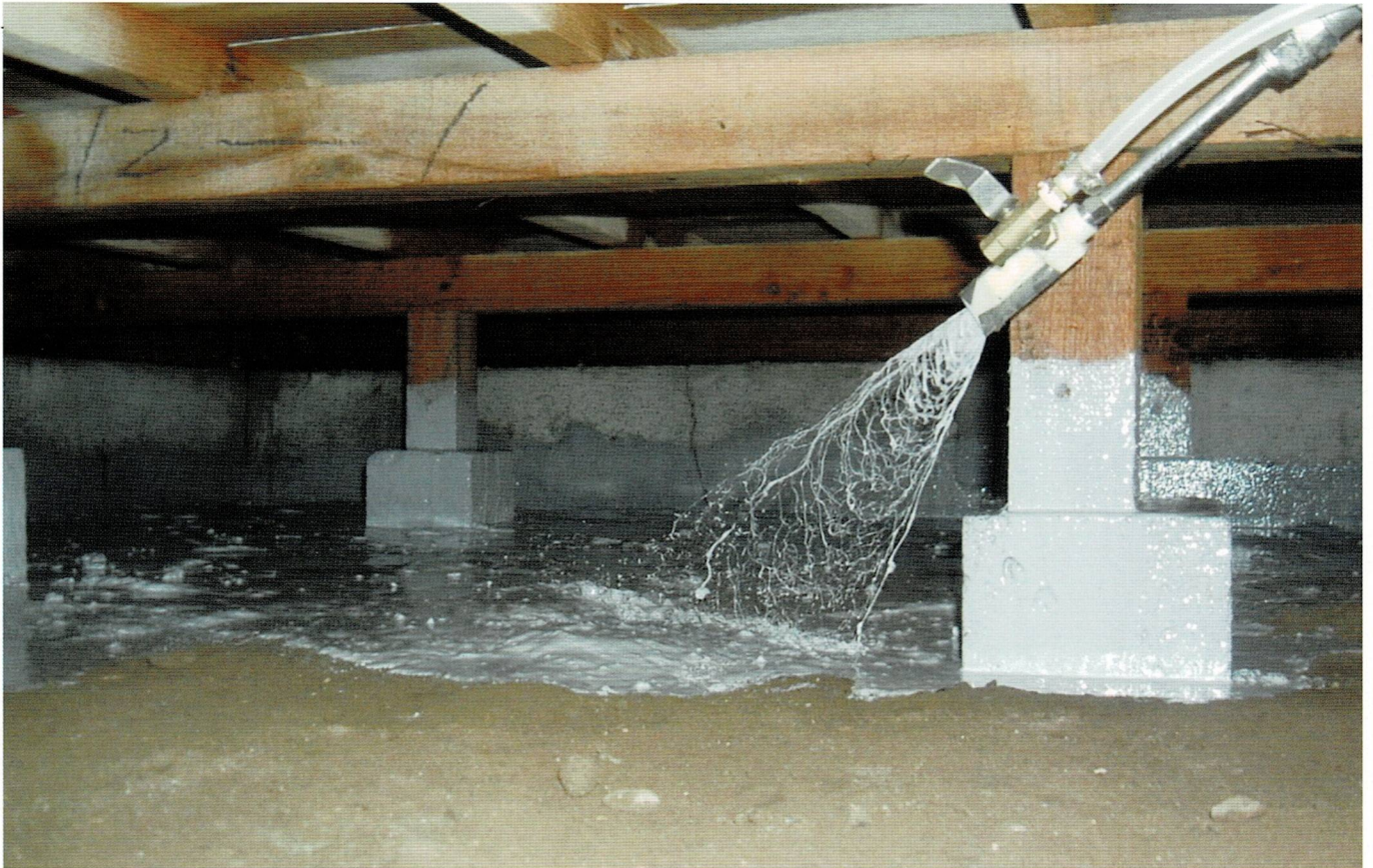
クリーンバリヤ（吹付け）状況
