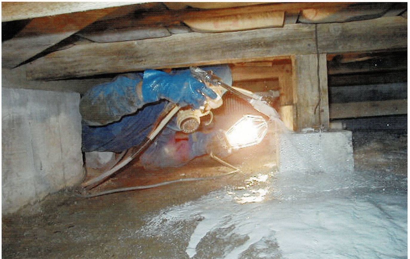
クリーンバリヤ（吹付け）状況
